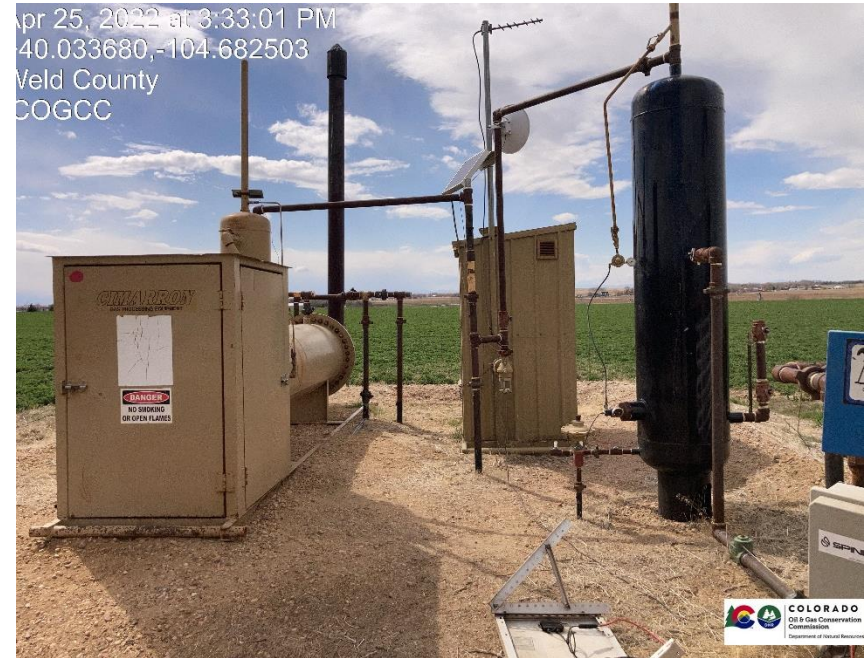
Pic 4 separatos, Gas meter run
