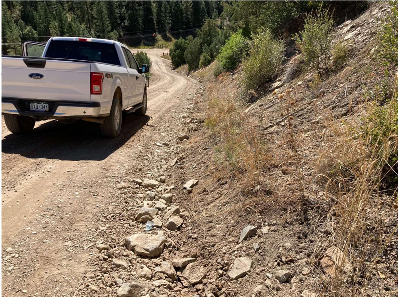
THE EXISTING RIP RAP IN THE BAR DITCH PROVIDES SOIL STABILIZATION AND EROSION CONTROL IN THE BAR DITCH.
