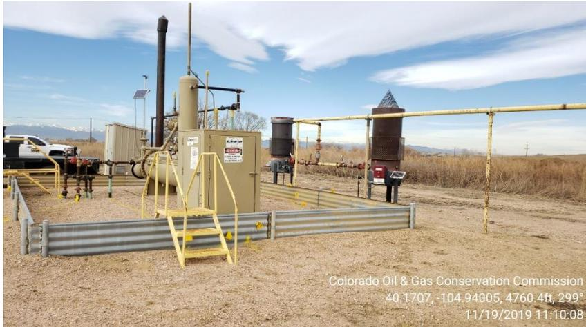
**Photo 5 Heated Horiz. Sep. Gas meter run and ECDs**
