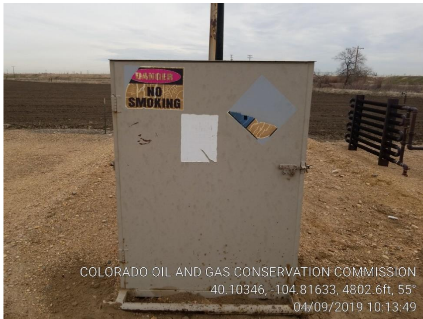
Pic 13 No NFPA Placard on Separator.
