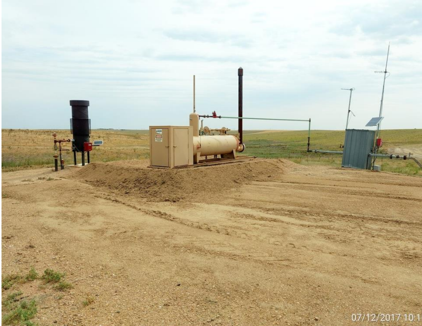
Separator, meter run, & ECD
